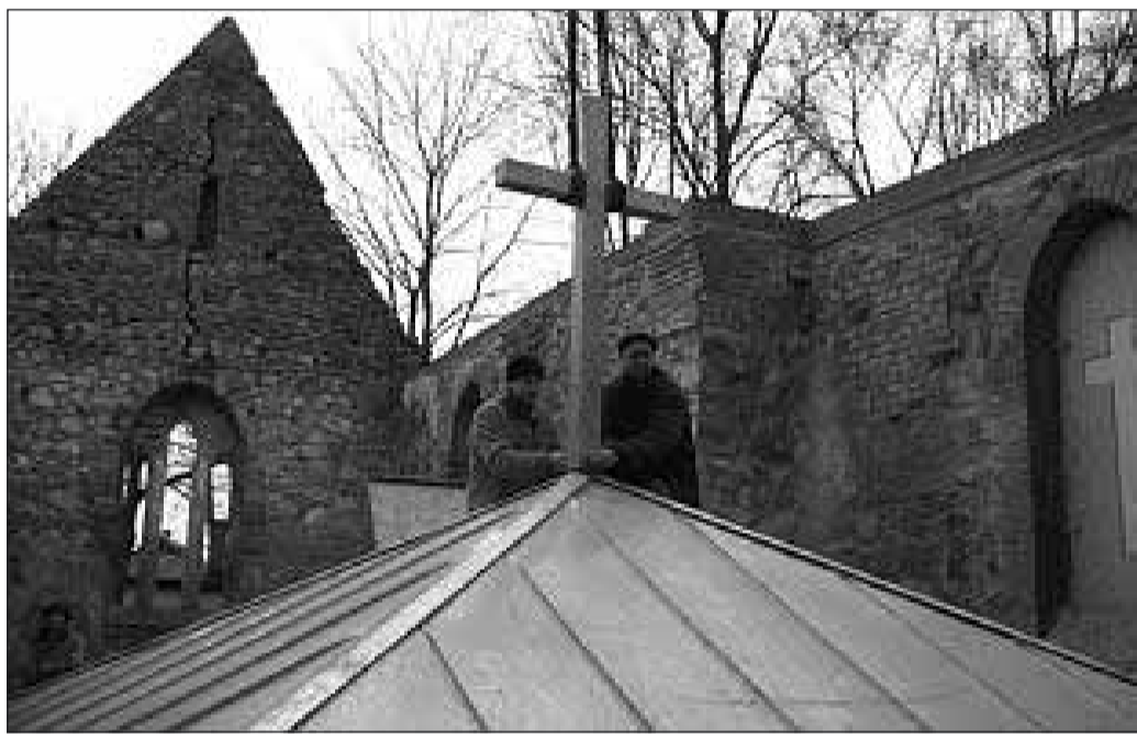
Gleich geht's gen Himmel: Metallbauer montieren das 40 Kilogramm schwere Stahlkreuz.
